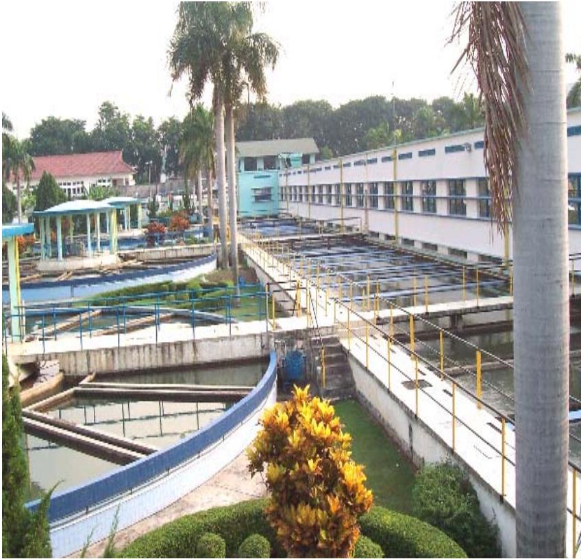
WTP Pejompongan 1 (Degremont 1953)
